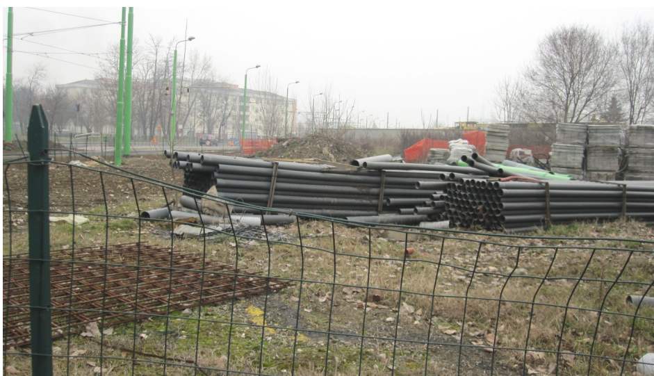
Area di via Anassagora—Tremelloni, ancora occupata dal materiale avanzato dai recenti lavori stradali.
